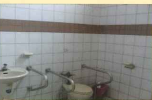
無障礙廁所施工前照片
