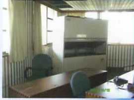
箱型冷氣安裝完工後照片
