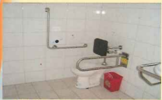
無障礙廁所完工後照片
