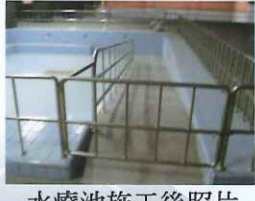
水療池施工後照片
