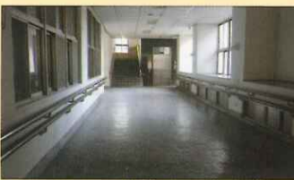
施工前木製扶手照片
