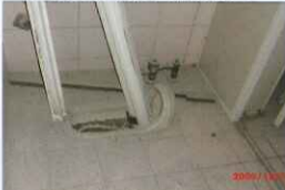
多感官施工前照片
