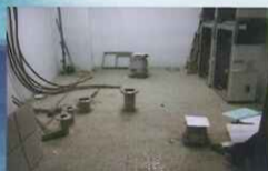
水療池施工前照片
