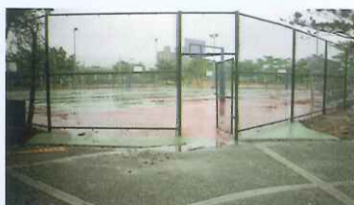
室外綜合球場完工後照片
