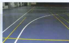
復健館三樓地板施工前照片
