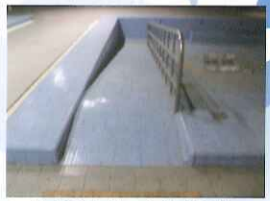
水療池施工前照片
