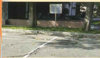
無障礙停車場施工前照片
