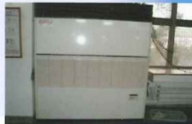
復健館空調安裝完工後照片
