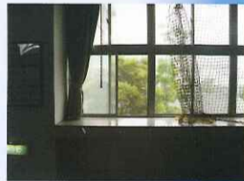
復健館施工前照片
