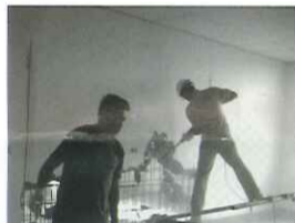
重量訓練室施工前照片
