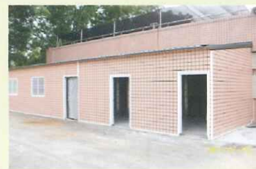
教學大樓一樓增設後
