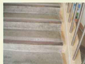
各大樓樓梯改善（增高）防護緣（改善後）
