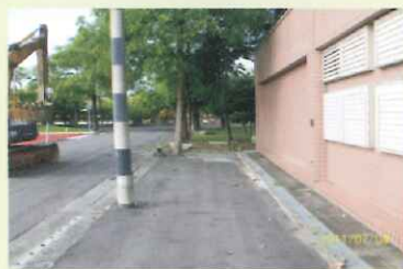
教學大樓一樓增設前
