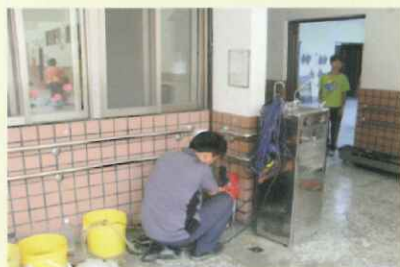
職教大樓二樓未裝設前
