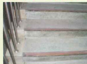
各大樓樓梯改善（增高）防護緣（改善前）
